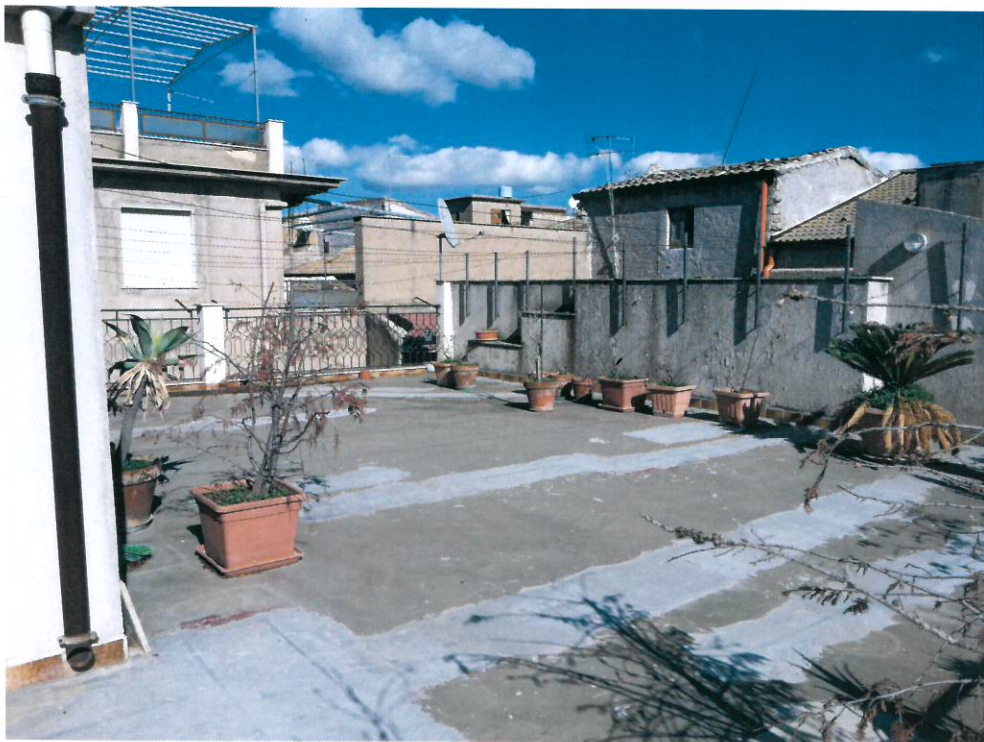
Foto n. 14: Terrazzo scoperto – Piano 2°
